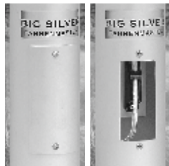
Seilklemme im Mast, mit Klappe verschlossen
