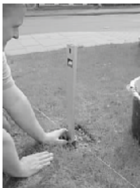
Ausrichten mit Wasserwaage
