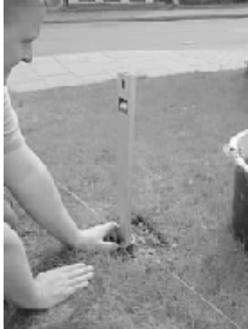
Ausrichten mit Wasserwaage
