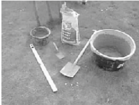
Mindestens erforderlich: Spaten, Estrichbeton, Betonkübel, Wasser, Wasserwaage.
