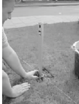
Ausrichten mit Wasserwaage
