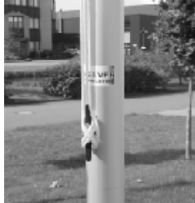
Abbildung 2 Klambefestigung am Mast
