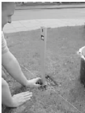
Ausrichten mit Wasserwaage
