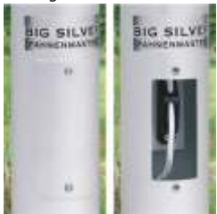
Seilklemme im Mast, mit Klappe verschlossen
