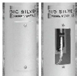
Seilklemme im Mast, mit Klappe verschlossen
