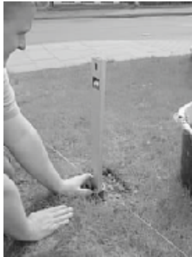
Ausrichten mit Wasserwaage
