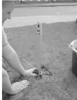
Ausrichten mit Wasserwaage
