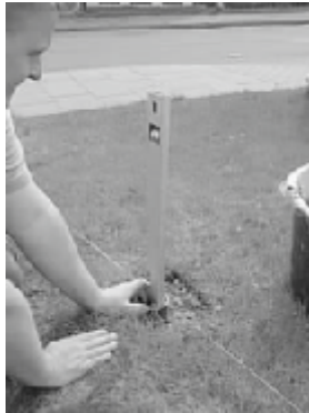
Ausrichten mit Wasserwaage
